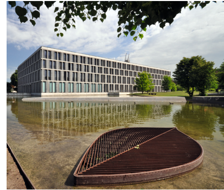
Bundesarbeitsgericht in Erfurt
